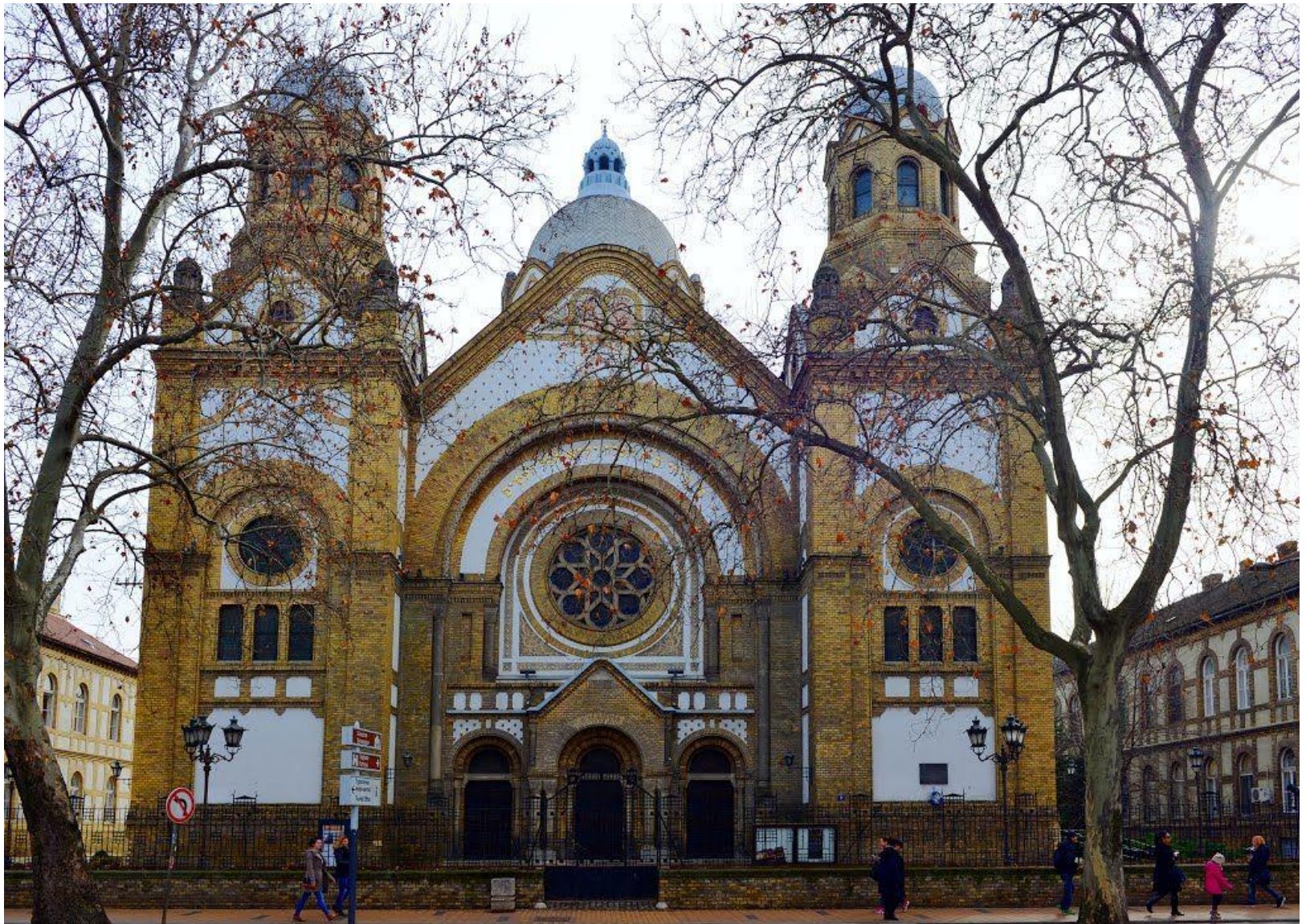
Sinagoga u Novom Sadu
